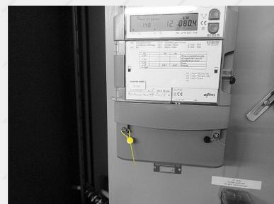
Sello de seguridad indicativa, diseñado para usar en contadores. Diámetro de la correa (1.95 mm), encaja en ojales pequeños. Sello plástico para reemplazar el sello de plomo tradicional. De una sola pieza - reciclable. Correas dentadas encajan en varias aplicaciones. Nombre / logotipo para identificación clara. Disponible en varios colores. Alicates para sellar el sello - logo en relieve disponible.
